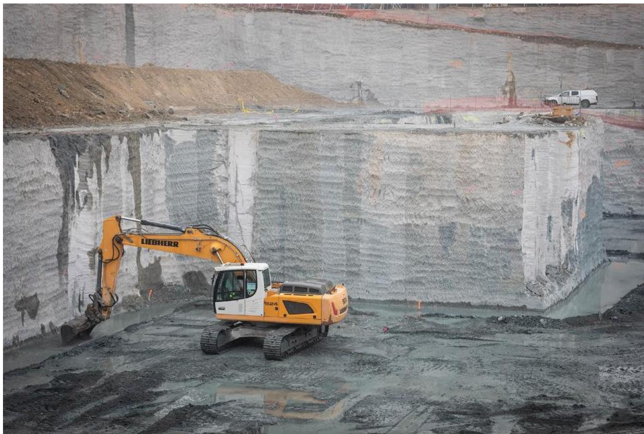
Paks II. Atomerőmű építési területe az 5. blokki nukleáris sziget munkagödrének omlással érintett Déli alsó padkafélsziget helyszíne. Fotó: Paks II. Zrt.
