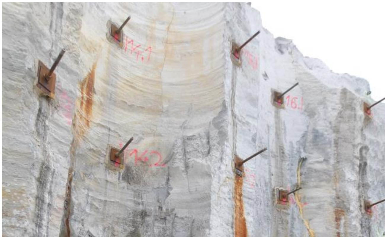
Paks II. Atomerőmű építési területe az 5. blokki nukleáris sziget munkagödrének talajszegekkel megerősített Északi alsó padkája. Fotó: OAH
